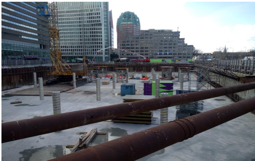
Figuur 1. Bouwkuip op donderdag 8 februari 2018
